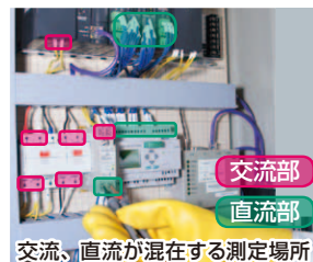
交流、直流が混在する測定場所
