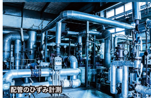
ブレーキや配管のひずみ計測
