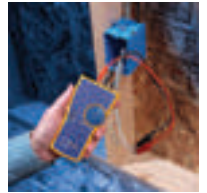
裸リード線への接続
