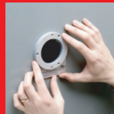
ネジで止めてパッキンをつけます。
