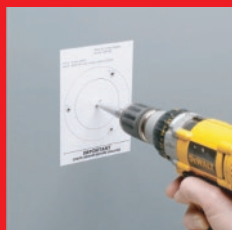
テンプレートにそって穴をあけます。
