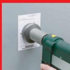
窓のサイズの穴をホールソーで開けます。
