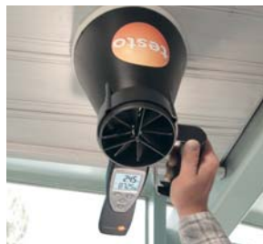
testo 417とφ200mmファンネルを使用して、排気口で風量測定
