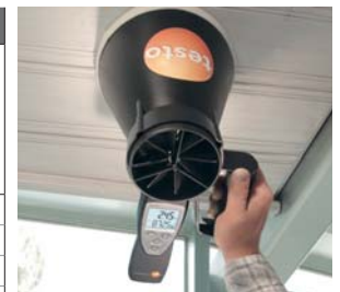
testo 417とφ200mmファンネルを使用して、排気口で風量測定
