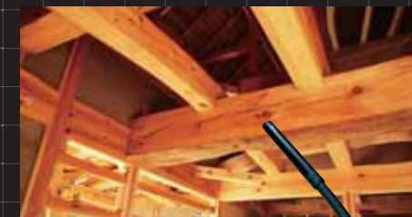
住宅: 壁・床下・天井裏・雨どいの確認
